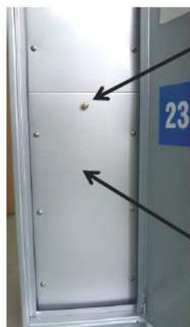
Anschlussklemmen hinter verschraubter Abdeckplatte
