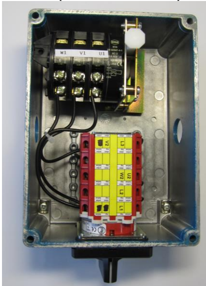
Motorschutz und Nockenschalter getrennt (Ohne Unterspannungsspule)
